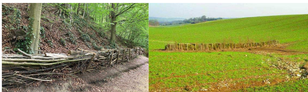
Figure 3 exemple de dispositif d'hydraulique douce - fascines
