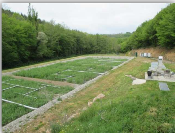
Photo 10 : Filtre plantés de roseaux (Beynat) © SATESE de la Corrèze
