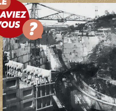
Construction en cours du barrage en 19...
