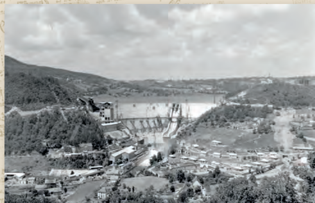
▲ Construction du barrage de Bort-les-Orgues : vue générale et cité ouvrière de Grange. 30 juin 1951. Arch. dép. Corrèze, 55NUM/94. Fonds Sully.
