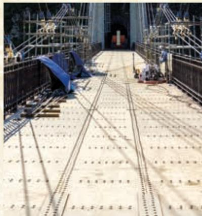
▲ Cette étape a représenté 100 tonnes de platelage pour 800 m<sup>2</sup> et démontage de 16 000 rivets.
