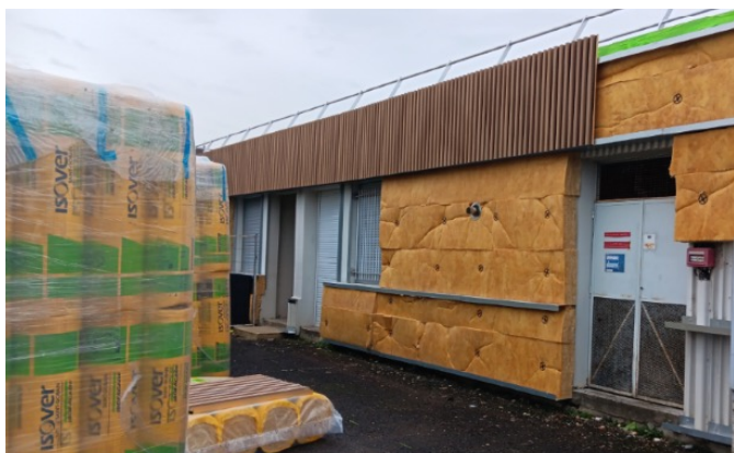
Travaux de rénovation énergétique du collège Rollinat
