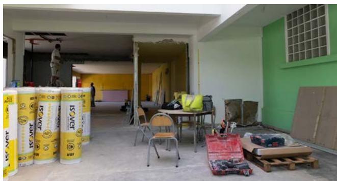
Rénovation et isolation d'un collège
