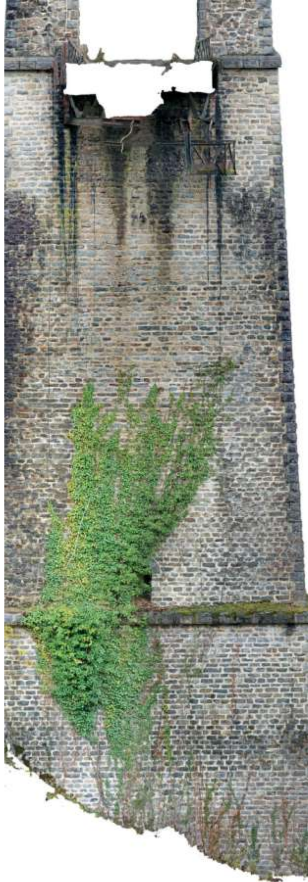
Pile rive droite, côté Lapeau
