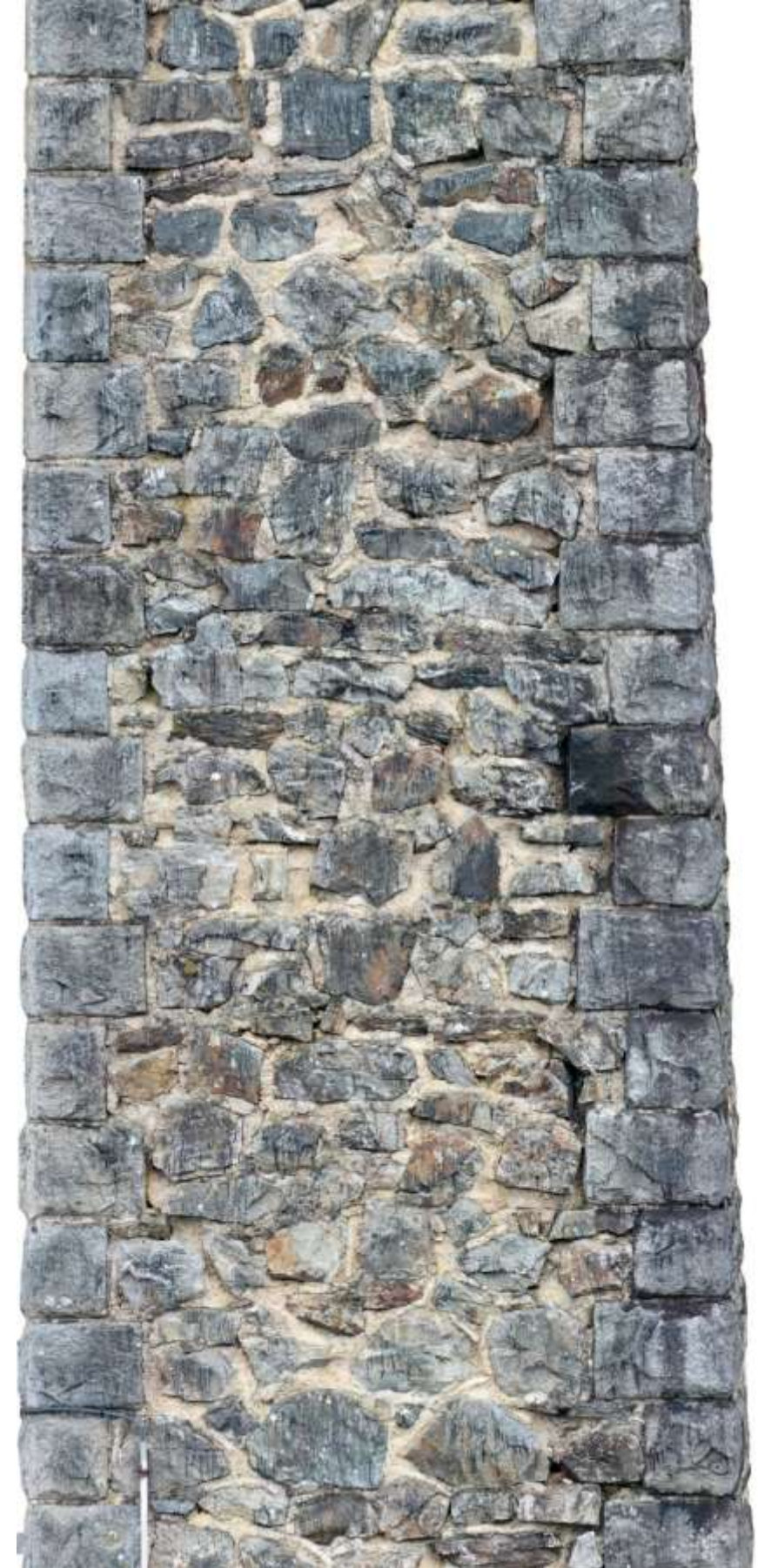
Pile rive droite, côté Lapeau
