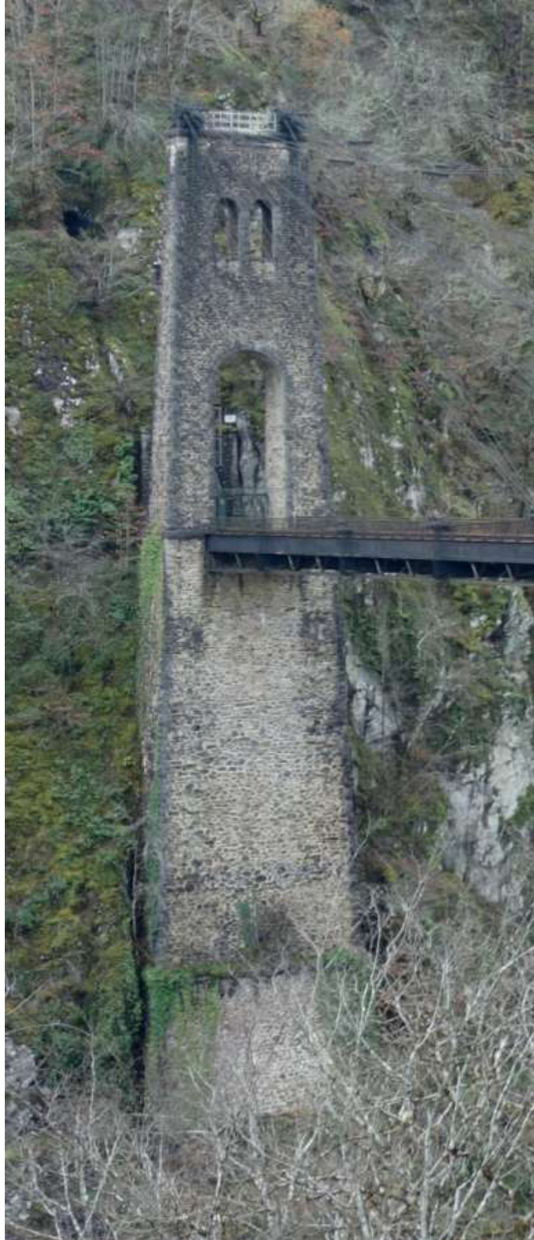
Pile rive gauche, côté Soursac
